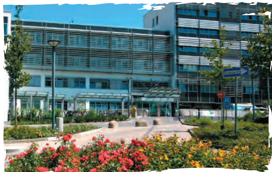
Außenansicht des St. Josef Krankenhauses.
